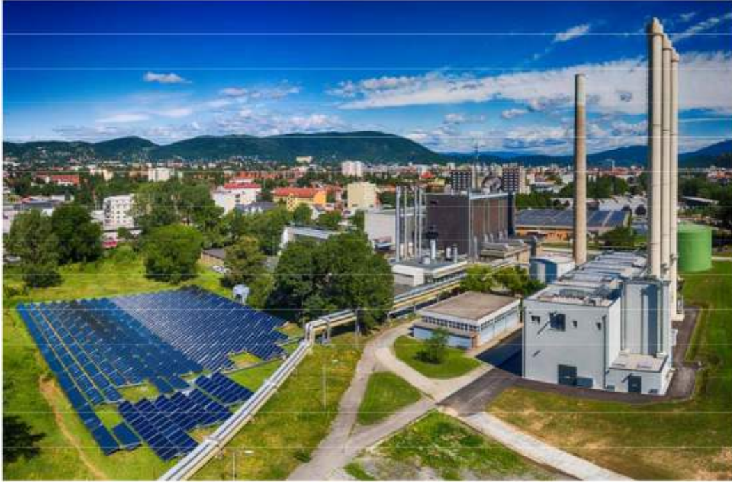
Akotec MEGA solarthermische energiecentrale in Graz, Oostenrijk
